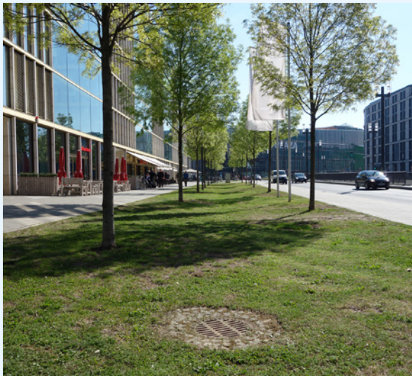
Seite 10: Frankfurt am Main, Europaviertel West. Baumquartiere in Kombination mit Sickermulden verbessern das Stadtklima und mindern die Überflutungsgefahr.
