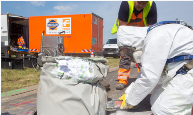
55 Schacht- und Großprofilsanierung am Flughafen Köln-Bonn
